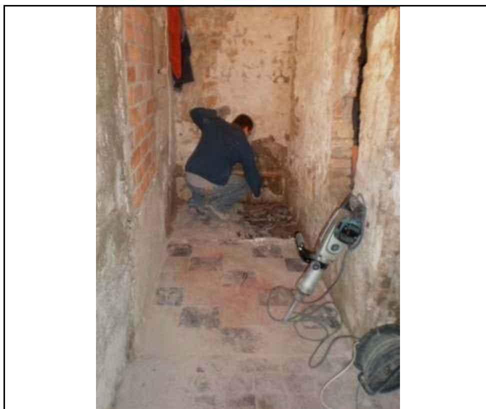
76. Zona nord de la finca. Tram inicial de la rasa de sanejament
