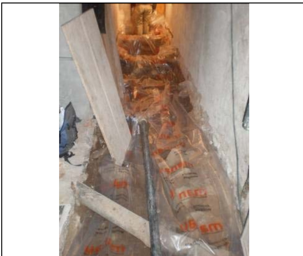
96. Cobriment provisional de les restes del vestíbul
