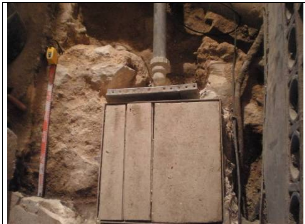
7. Mur de façana 2022, afectat per arqueta 2005
