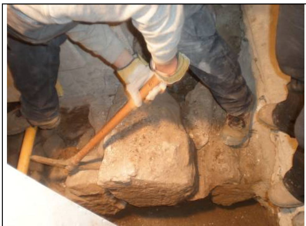
100. Desmuntatge de l'estructura 2016
