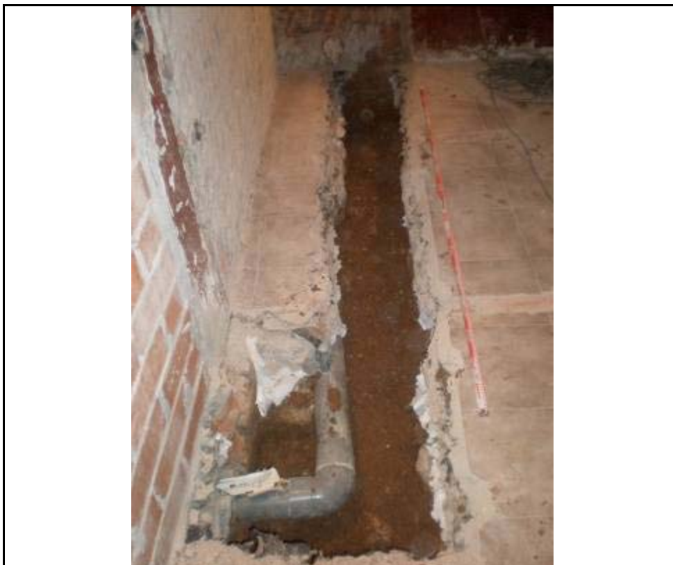
95. Darrer tram de rasa a la crugia est de l'edifici. Final
