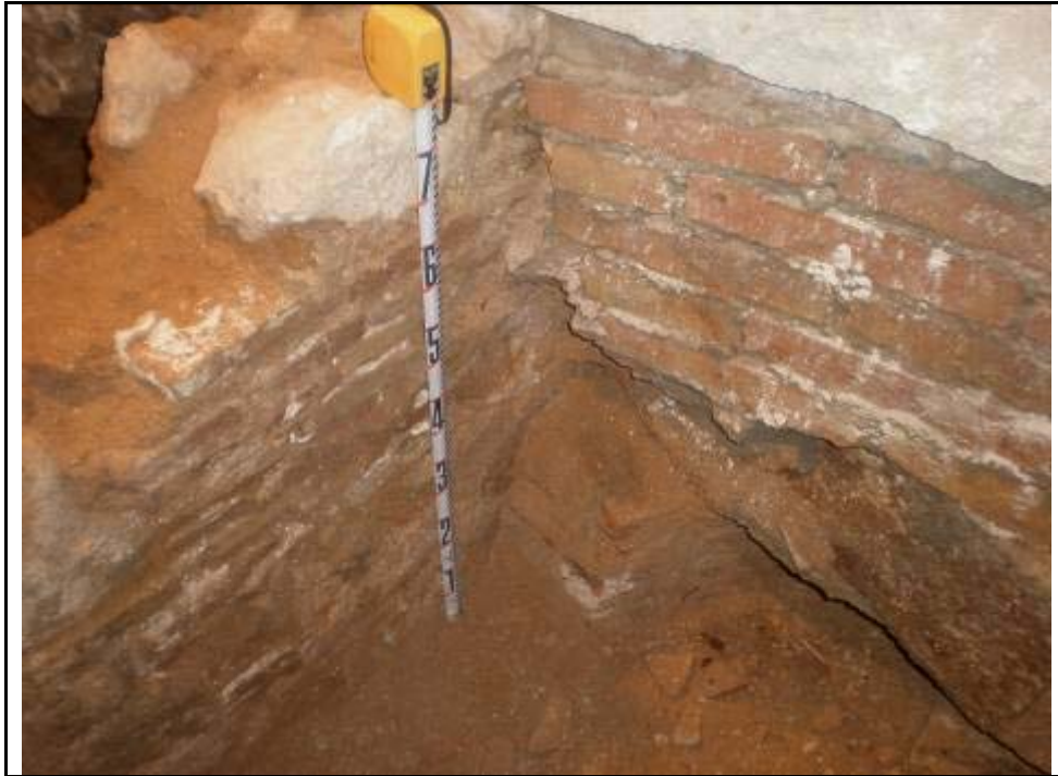
51. Detall del mur 2006 i el mur de descàrrega oest del vestíbul
