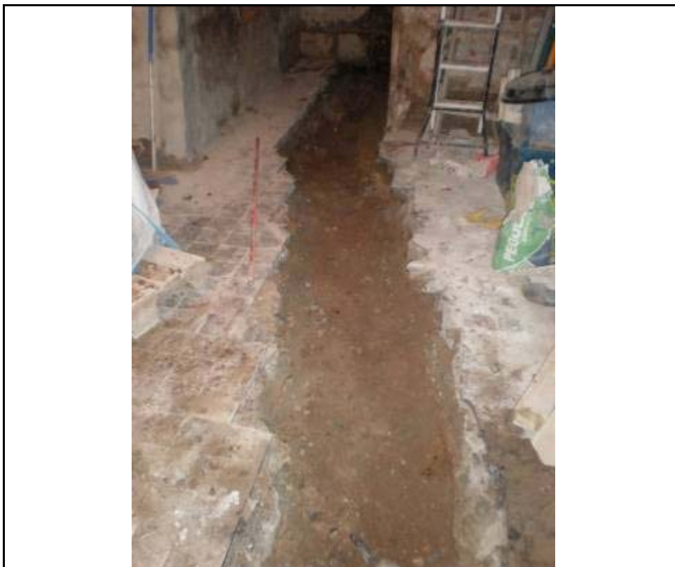
77. Tram inicial de la rasa de sanejament després de la retirada del paviment
