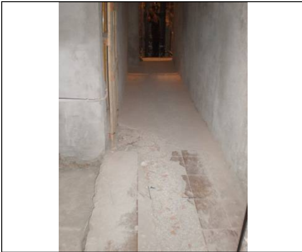
1. Àrea del vestíbul abans de la intervenció
