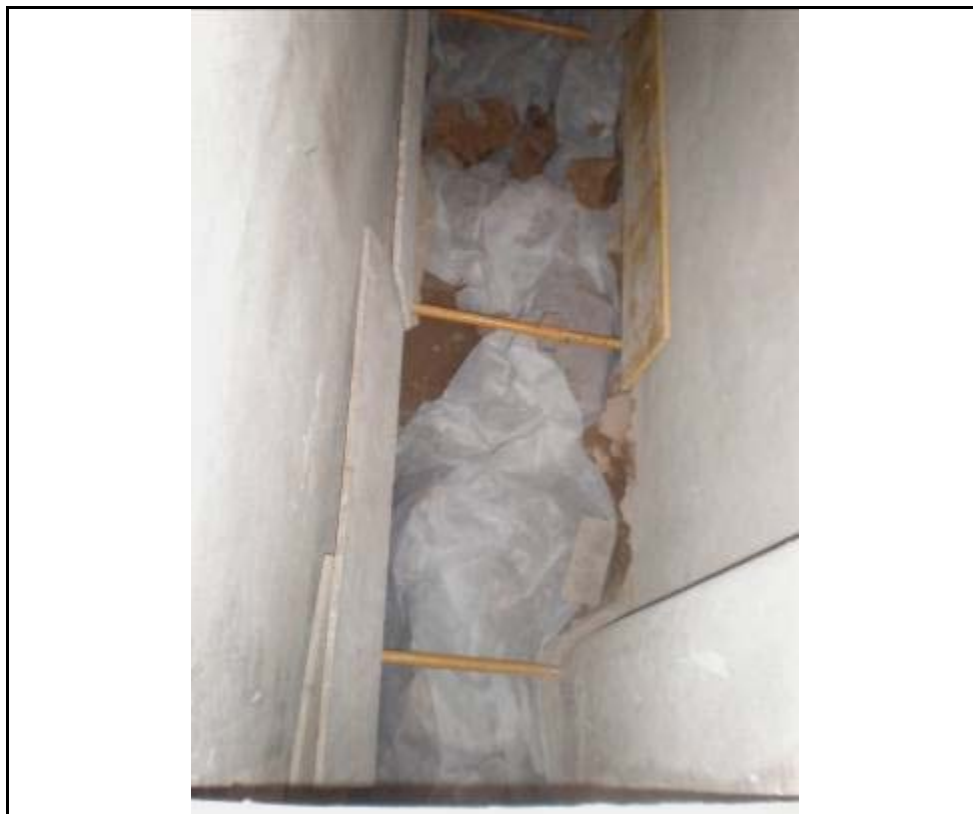
103. Cobriment d'estructures a la zona del vestíbul
