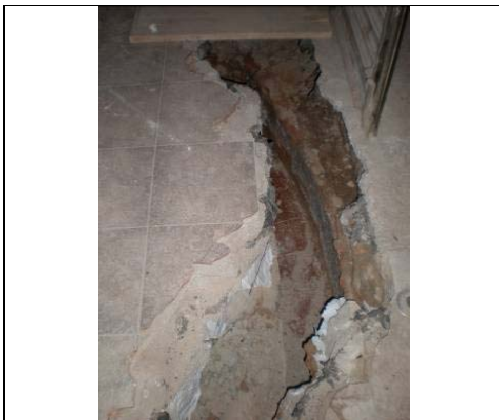
34. Antic col·lector de la façana est. UE 2065
