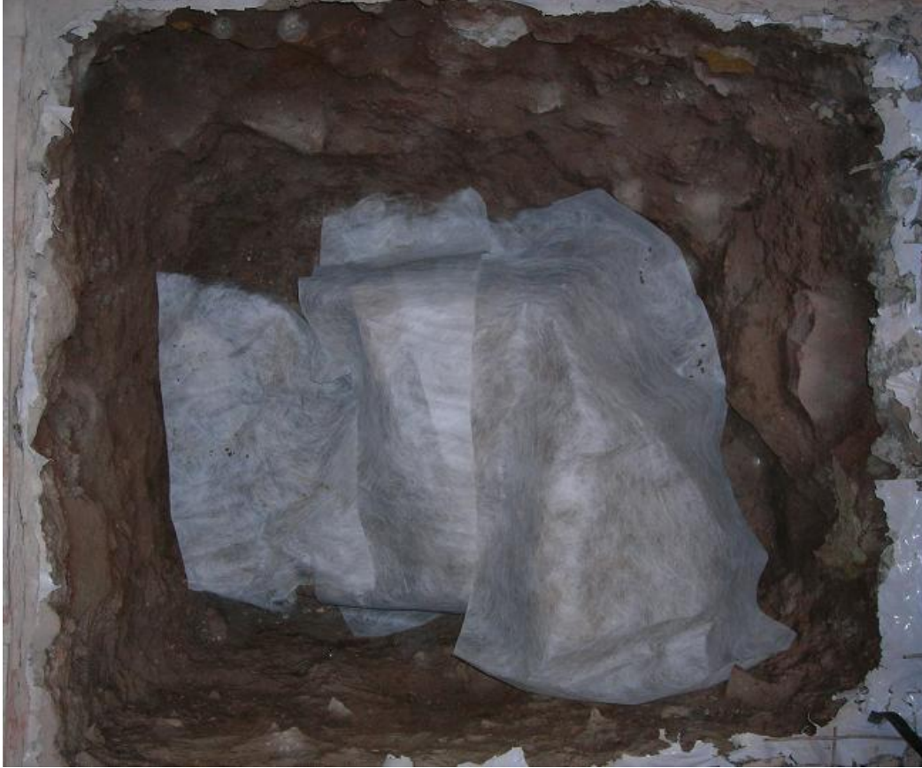
Fotografia 13 Detall de les restes tapades amb geotèxtil per a la seva protecció en el seu cubriment en el decurs de l'obra
