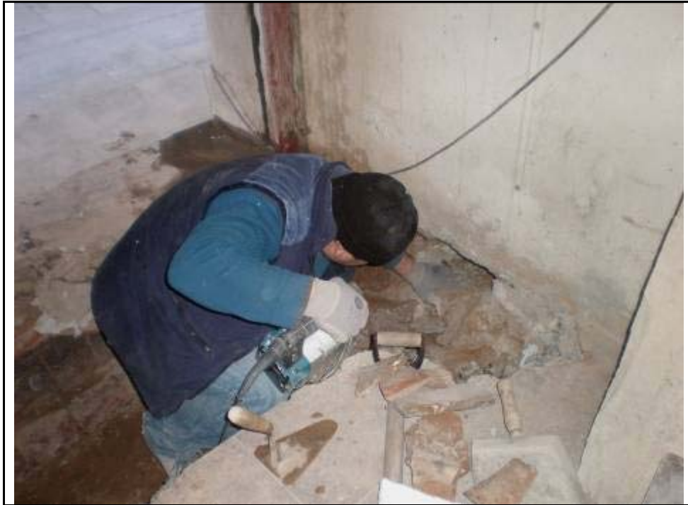
35. Extracció d'un tub en desús que afecta el mur 2023
