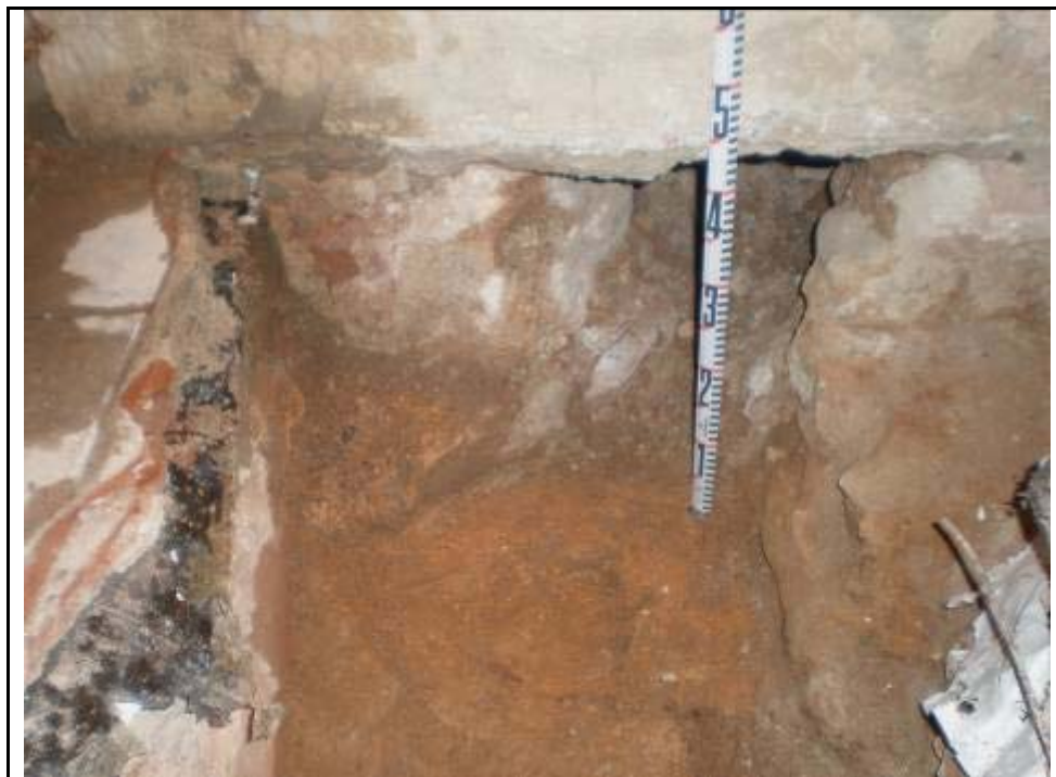
37. Perforació al mur 2023 per la instal·lació d'un servei
