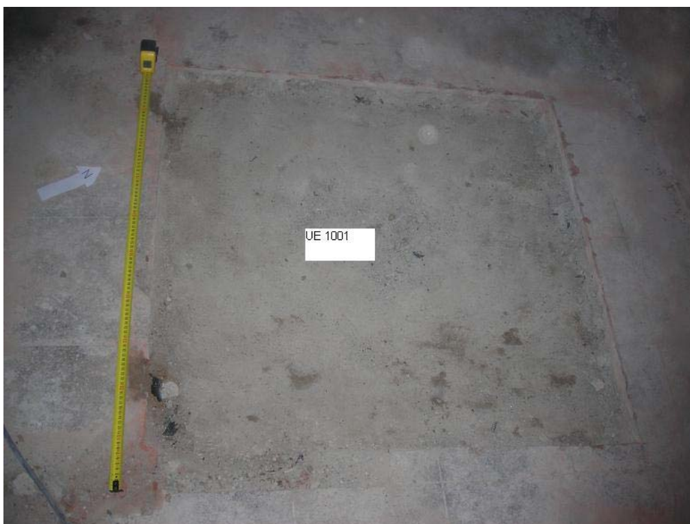
Fotografia 2 Preparació paviment actual UE 1001
