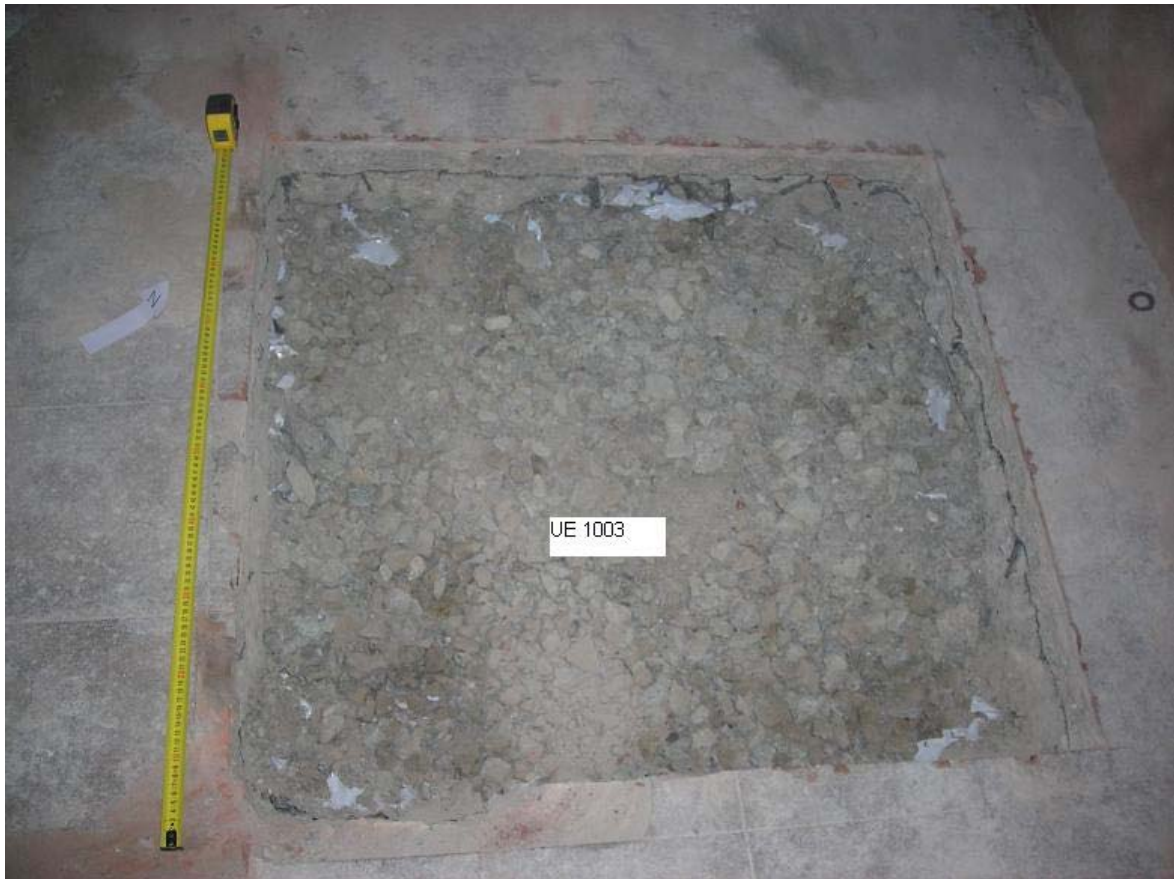
Fotografia 3 Anivellament de la preparació del paviment actual. UE 1003
