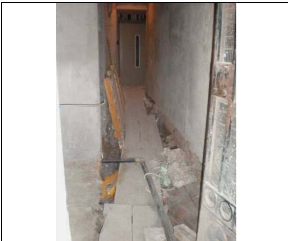
97. Passarel·la provisional de la zona del vestíbul instal·lada durant l'excavació
