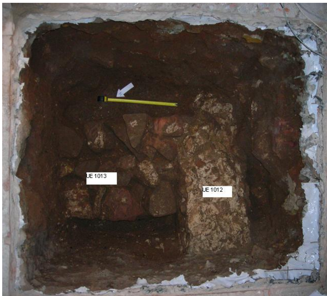
Fotografia 10 Observació de com el mur UE 1013 s'adosa al mur UE 1012
