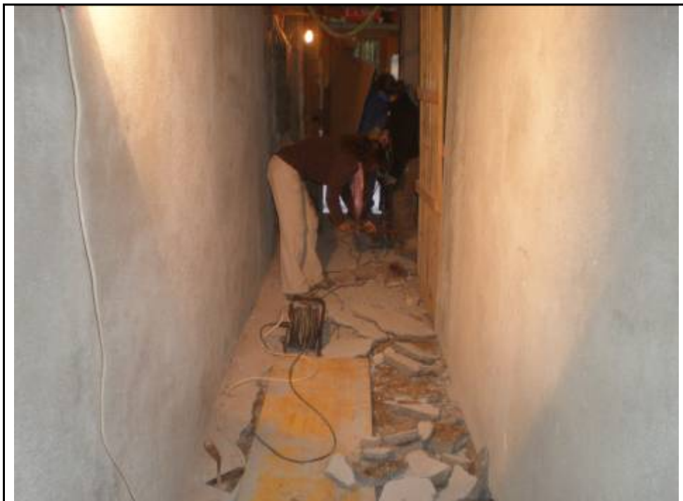
2. Tasques de retirada del paviment
