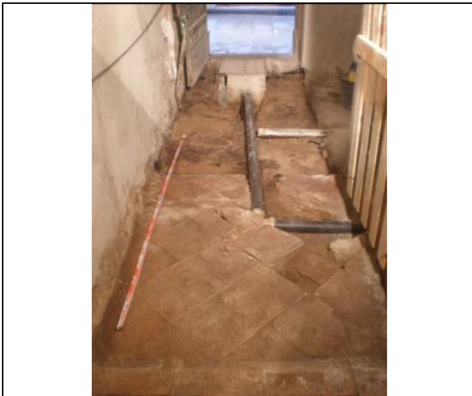
4. Paviment 2002. A l'entrada només es conserva la seva preparació
