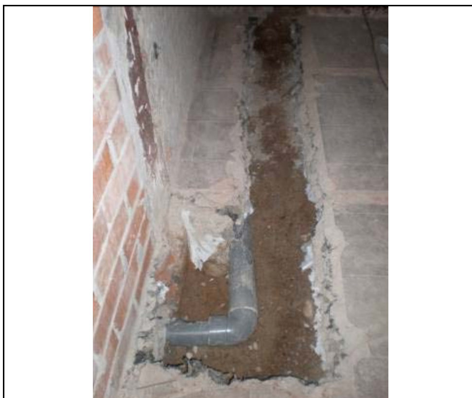
94. Darrer tram de rasa a la crugia est de l'edifici. Inicial
