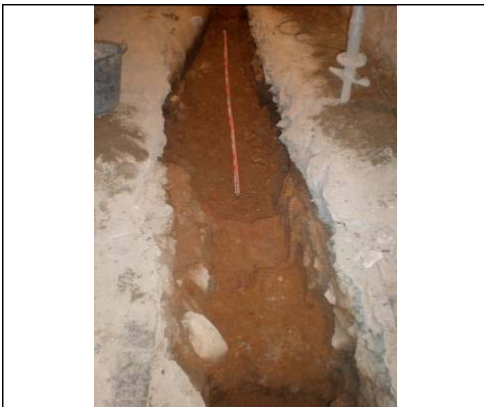
90. Mur baixmedieval 2118 i farciment de runa 2122 relacionat amb el col·lector
